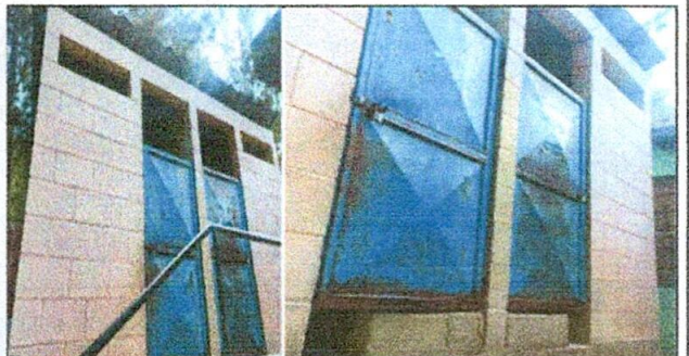
Foto 6: Sustrucción de puertas.
