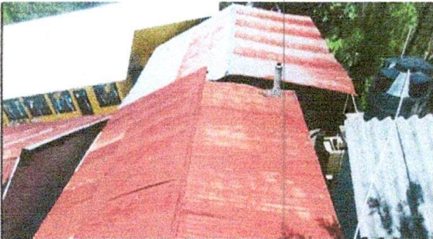
Foto 3: Sustrucción de lamina aula 5
