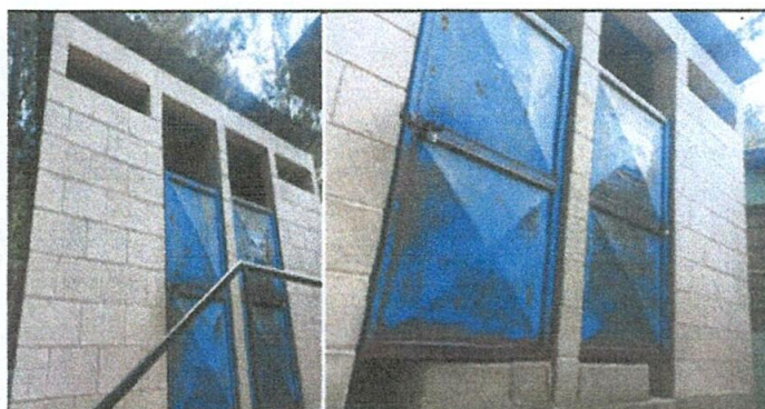
Foto 6: Sustitución de puertas.
