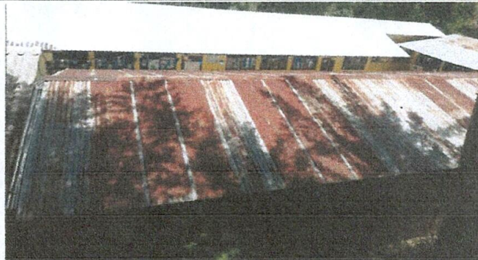
Foto 2: Sustitución de lamina aula 3 y 4
