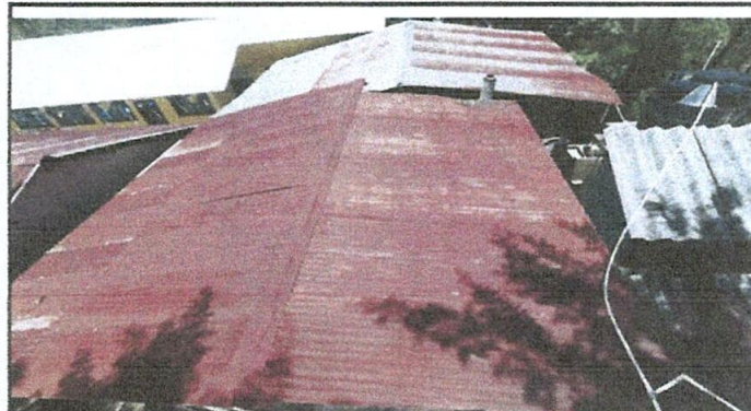
Foto 4: Sustitución de lamina de la cocina.
