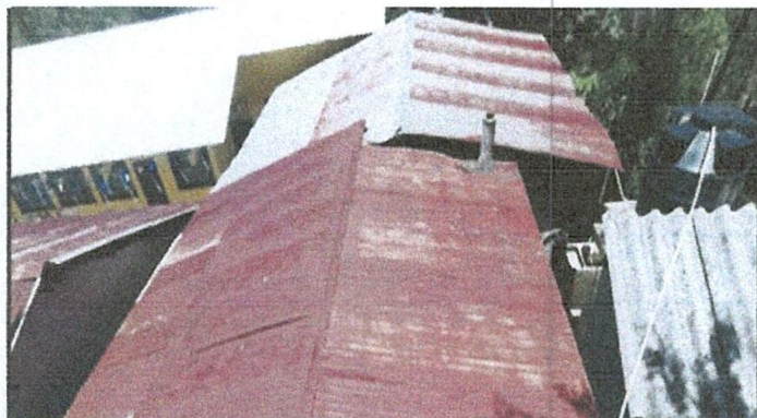
Foto 3: Sustitución de lamina aula 5
