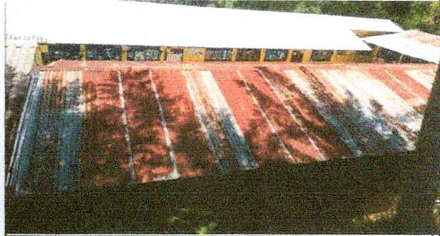
Foto 2: Sustrucción de lamina aula 3 y 4
